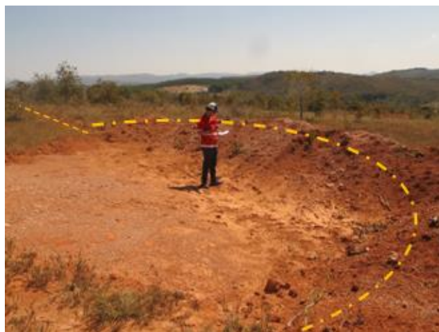
Foto 6: Georreferenciamento para implantação de terraços com barraginhas tipo 2. (17/08/16)
